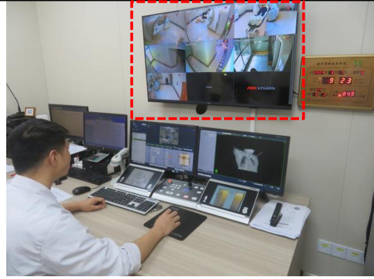
图 3-15 机房内监控视频
