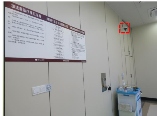
图 3-21 机房内摄像头（机房北侧）
