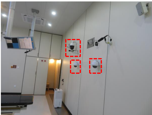
图 3-18 机房内摄像头（机房西侧）
