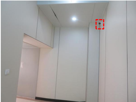
图 3-16 机房内摄像头（机房入口）
